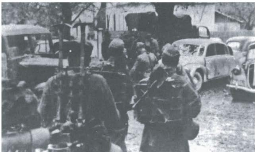
Mínometníci z I. práporu skupiny „Schill“ postupujú na Banskú Bystricu ( Aufstand in der Tatra )
