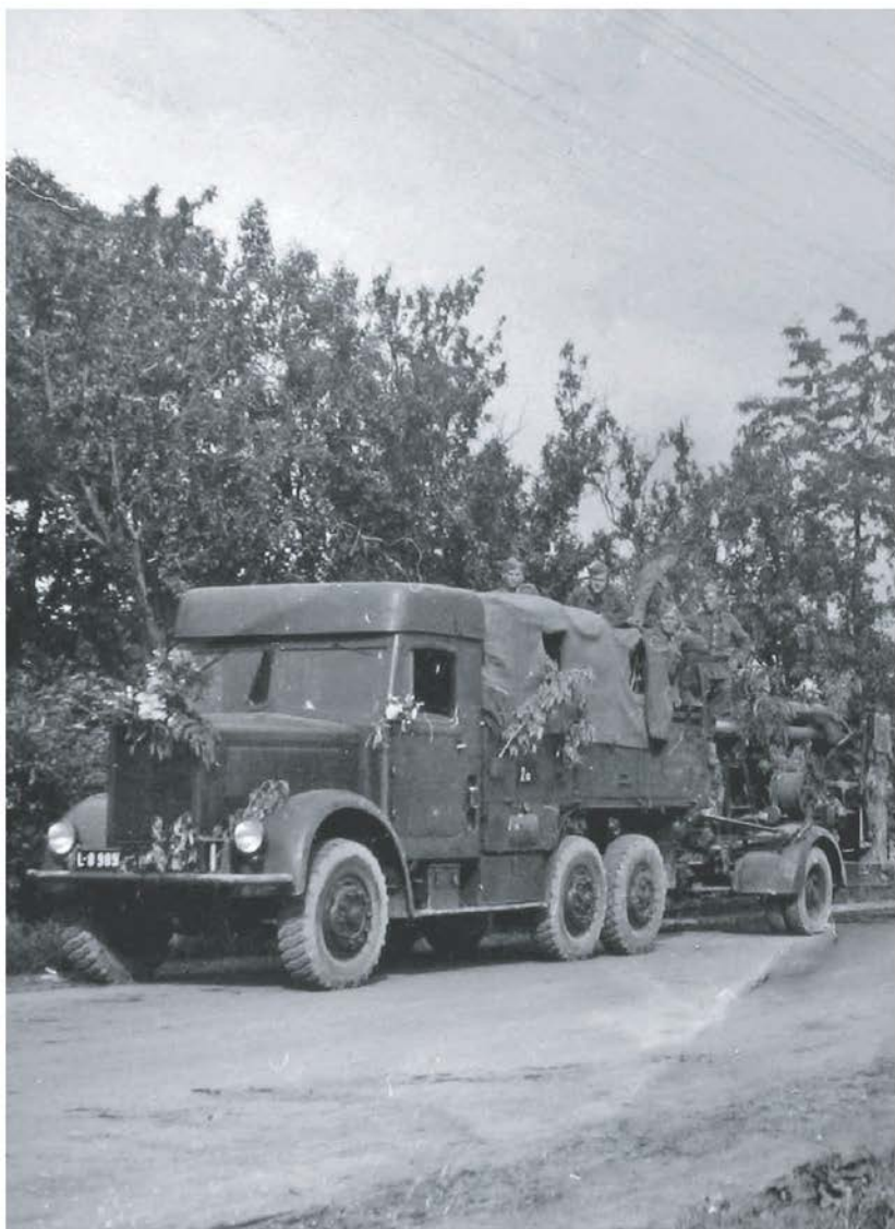
Presun 18. protiletadlovej batérie na front pri Sv. Kríži nad Hronom. Ako ťahače kanónov 88mm Flak 37 použili povstalci nákladné automobily Škoda 6 ST 6-L ( sk.wikipedia.org )
