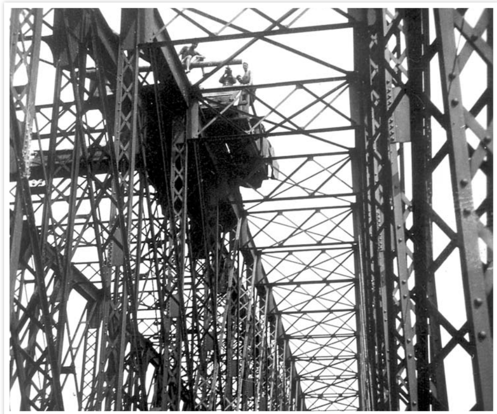
Pohľad na stanovište kanóna protivzdušnej obrany umiestneného na najvyššom oblúku Starého bratislavského mosta
