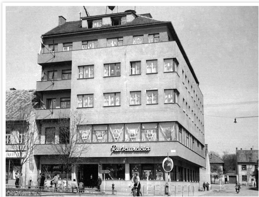
Hotel Hviezda s kaviarňou na prvom poschodí
